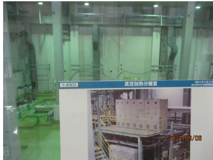
施設が撤去された真空加熱分離室
