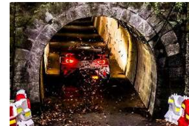
伊世賀美隧道 (旧伊勢神トンネル)
