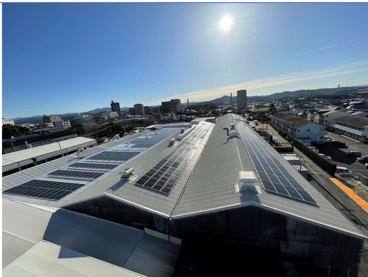
新エネルギーの一つである（太陽光パネル）を設置した工場の例
