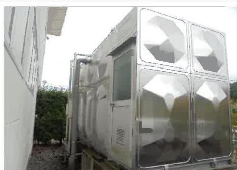
給水用タンクの本体、架台に損傷、変形、腐食等の劣化、又は当該部分からタンクの外部に漏水の痕跡はないか。
