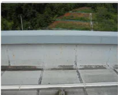
パラペットに浮き、き裂、損傷、白華、腐食、漏水痕等はないか。
