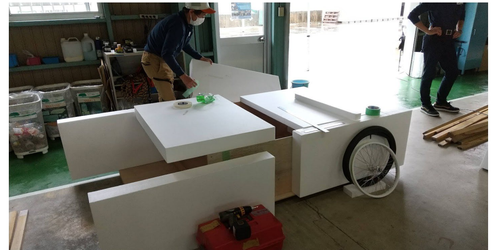
切断した発泡スチロールを木枠に仮固定
