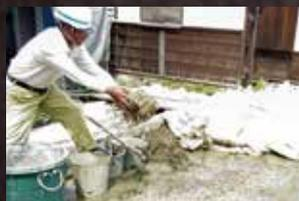
日本古来の建物は、地域に根ざした自然素材を上手に使って造られました。旧鈴木家住宅の保存修理では、残された部材一つ一つを大切に、極力残すことを徹底しています。例えば、壁の修理では一度解体した土壁の土も再利用します。集めた土に藁や砂、水を加えて練り発酵させることで、粘り気のある良質な左官材になるのです。他にも、屋根瓦は一枚一枚使えるものかどうかを見極めたり、柱や梁などの木材は大工の伝統的技術により、使えない部分だけを新材で補てんしたりしています。
