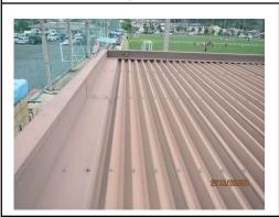
パラペットに浮き、き裂、損傷、白華、腐食、漏水痕等はないか。
