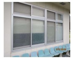
窓の枠やシーリング材等に腐食、き裂などの劣化はないか。
