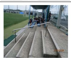
通路、スロープの手すり本体、支持部材及び支 柱埋設部に著しい損傷、変形、腐食、ぐらつきは ないか。 (根元・地際は特に注意)
