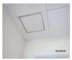
点検口本体及び枠にずれ、変形、腐食等はない か。
