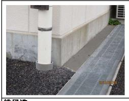
周辺地盤と比較して沈下又は隆起、き裂その他 損傷はないか。
