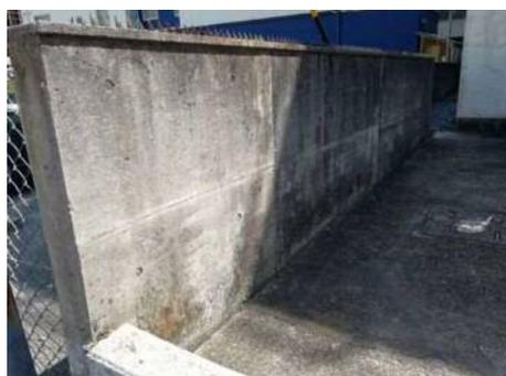
コンクリート、ブロック等の塀に著しいき裂等の劣化、損傷あるいは傾き等はないか。
