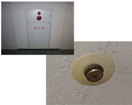
消火栓箱に著しい損傷、変形、腐食はないか。
