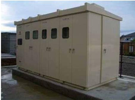
受変電設備盤外板に著しい損傷、変形、腐食はないか。
