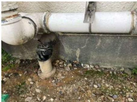
配管、バルブに損傷、変形、腐食等の劣化がみられ、かつ、当該部分から外部に漏水、油漏れの痕跡はないか。
