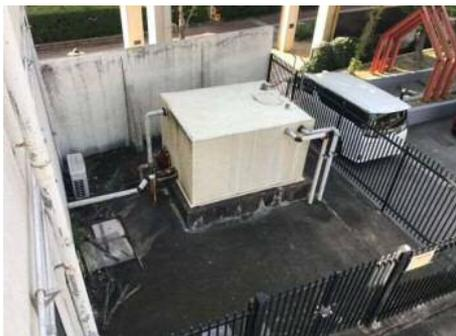
給水用タンクの本体、架台に損傷、変形、腐食等の劣化、又は当該部分からタンクの外部に漏水の痕跡はないか。
