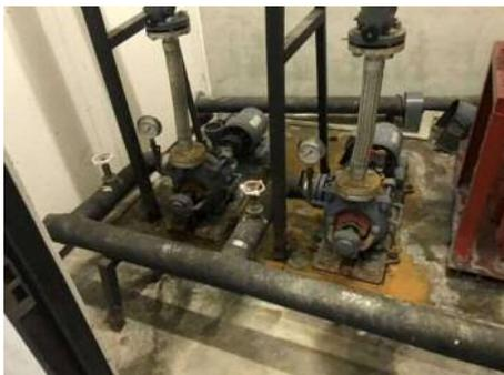
本体に損傷、変形、き裂、水漏れ等はないか。
