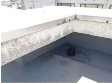
パラペットに浮き、き裂、損傷、白華、腐食、漏水痕等はないか。
