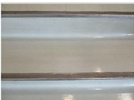
階段の滑り止めが浮き、欠損、変形等で歩行に支障はないか。
