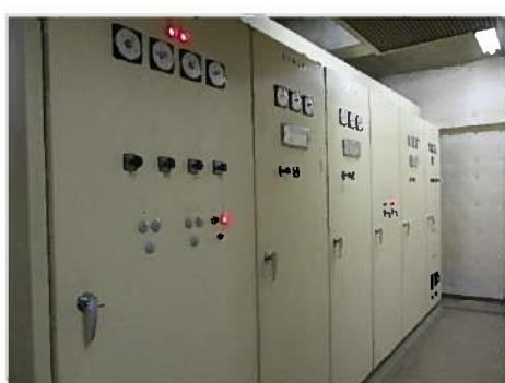
受変電設備盤外板に著しい損傷、変形、腐食はないか。
