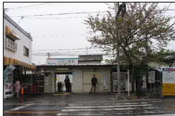
高架化工事着手前に撮影(平成15年)
