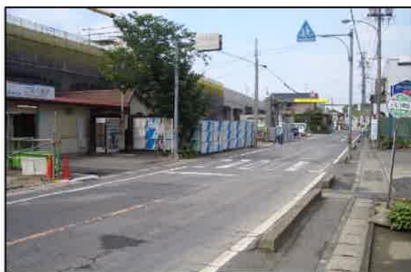
高架化工事中に撮影(平成21年)
