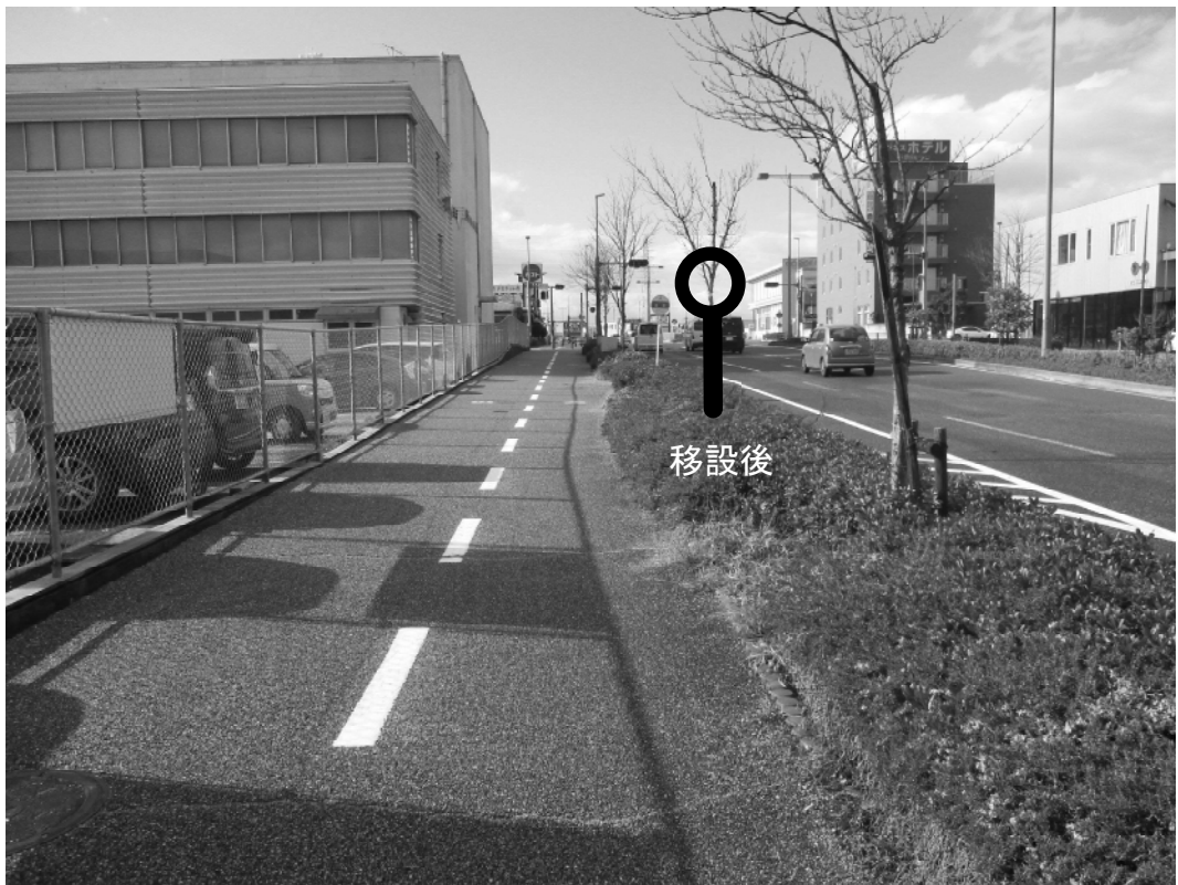
写真1 状況写真（寿町バス停・下り）
