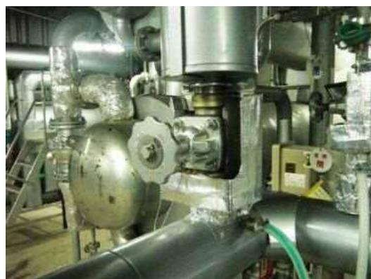
手動ダイヤフラム弁への受け皿の設置状況（横配管（左上）と縦配管（右上））
