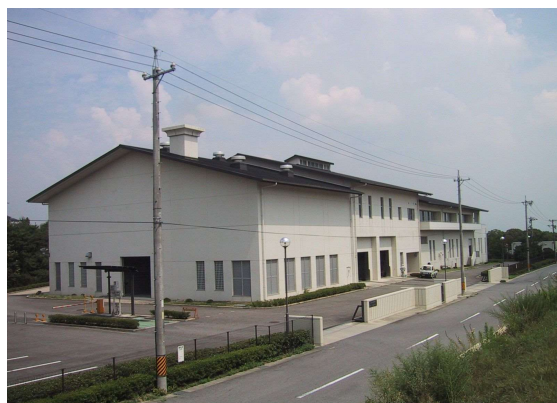
砂川衛生プラント
