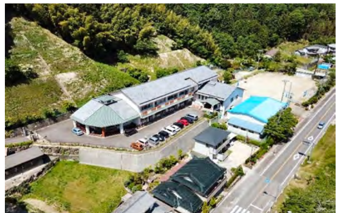
平成10年竣工 新校舎
