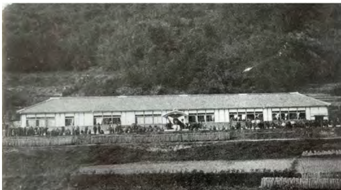
大正5年竣工 旧校舎
