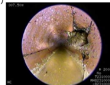
管内の破損状況 (管路TVカメラ調査)
