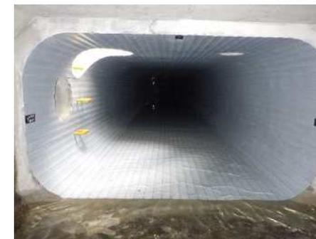
雨水幹線耐震補強工事 (管更生)
