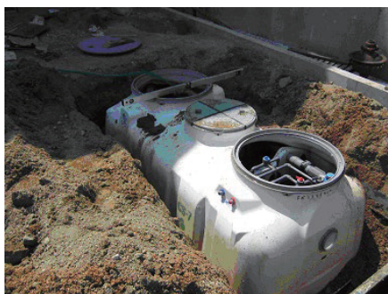
合併処理浄化槽の設置工事
