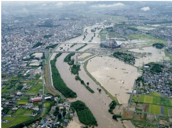
H12.6 東海豪雨【豊田スタジアム付近】
