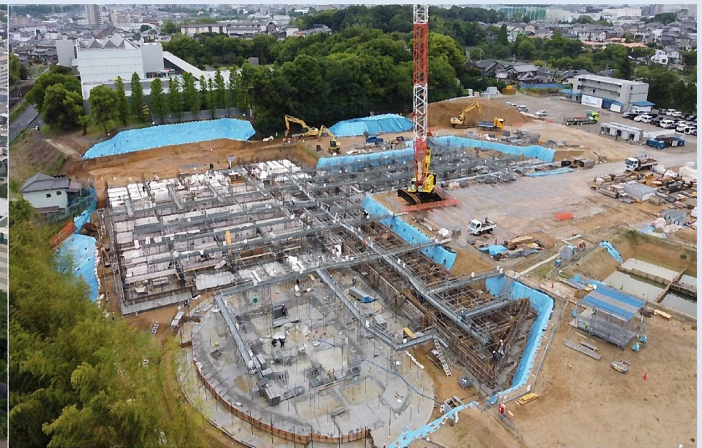
整備後 (施行中)
