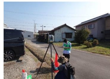
写真8 3D スキャナによる現地測量の様子
