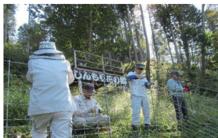
獣害対策用フェンス設置の様子
