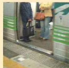
〈新豊田駅〉 ホームの嵩上げ を行い、車両と ホームの段差を 解消しました。
