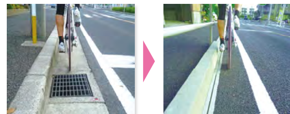
▲車道端部の構造を自転車走行に配慮し改良した案 〔出典〕東京都建設局新技術情報データベース
