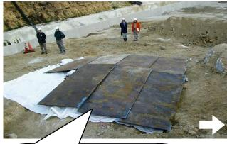
3 重の発破防護工 (鉄板・防爆シート・ブラスティングマット)
