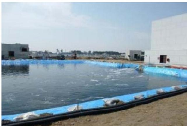
図 5-11 仮設沈殿池を用いた簡易処理
