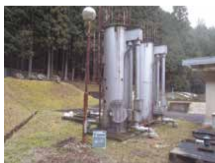
(水道ストックマネジメント計画による実績例 日下部浄水場活性炭吸着設備)
