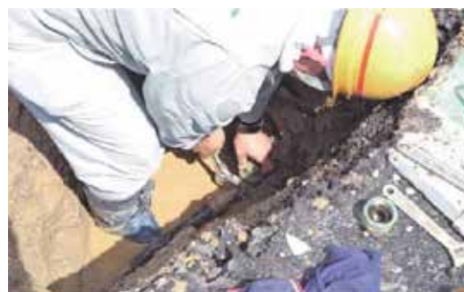
（漏水修繕工事）
