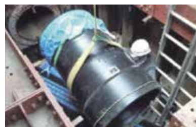
（水道管の耐震化工事）
