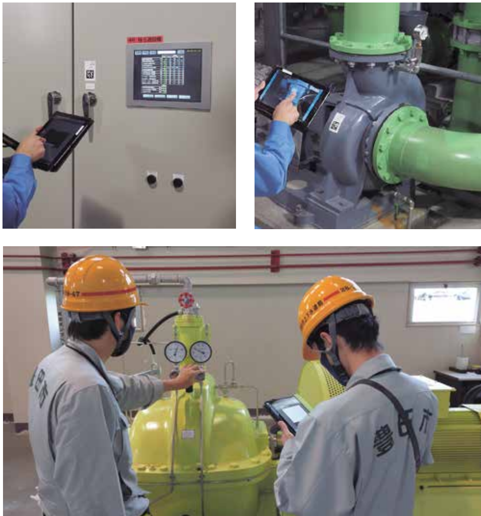
【現場点検システム 運用状況】
