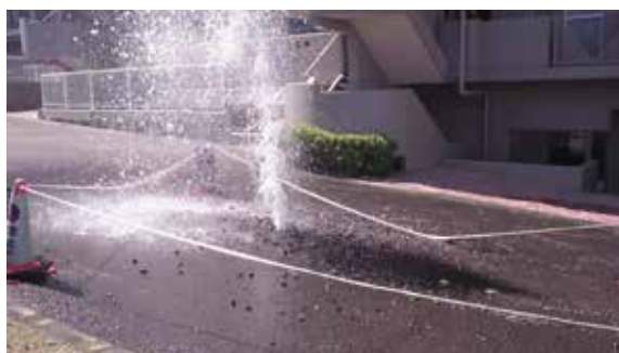
（水道管の漏水）
