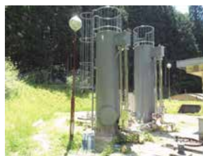
(水道ストックマネジメント計画による実績例 日下部浄水場活性炭吸着設備)
