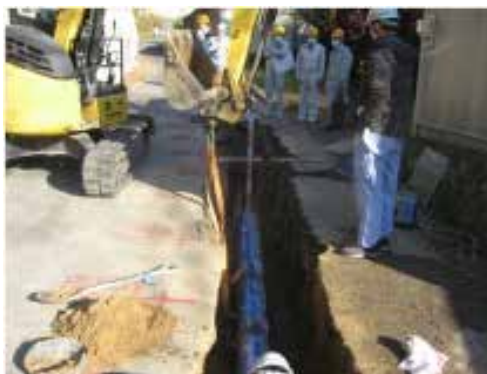
(水道管の耐震化工事)
