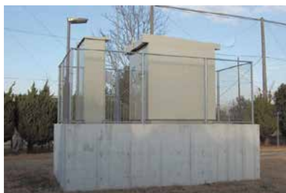
(耐水化対策例：施設のかさ上げ)
