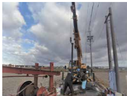
（取水井の浚渫工事）
