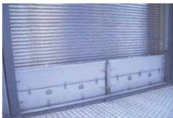
(耐水化対策例：止水板の設置)
