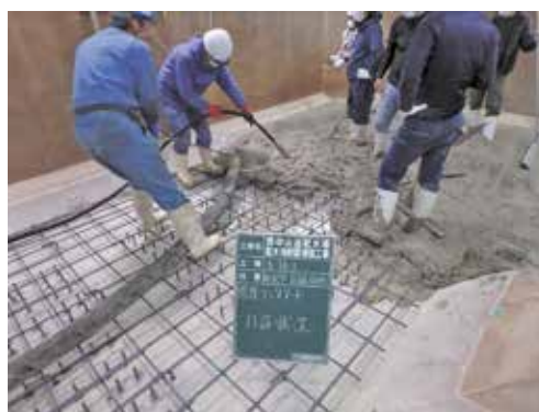
（配水池の耐震補強工事）
