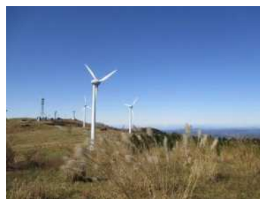
面ノ木風力発電所
