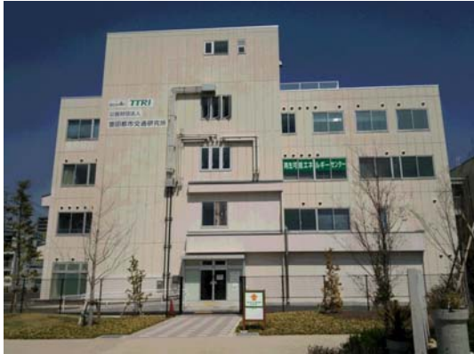
建物3階が再エネセンター
