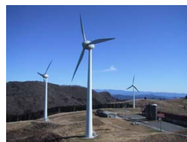
面ノ木風力発電所
