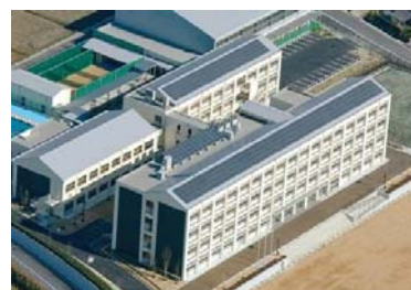
藤岡南中学校の太陽光発電
