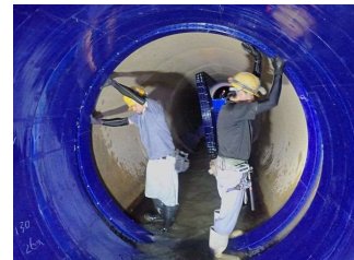
雨水幹線耐震補強工事 (3S工法)
