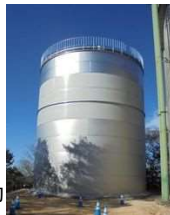
東山配水池の耐震化
