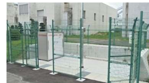
災害拠点給水施設
