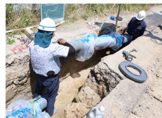
水道管整備工事
