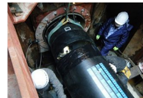
水道管の耐震化工事
