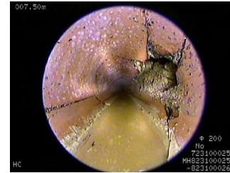
管内の破損状況 (管路TVカメラ調査)
