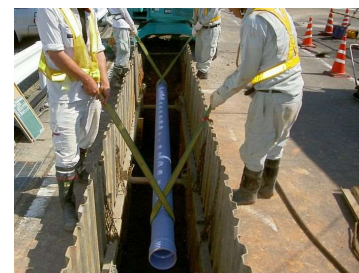
管路築造工事 (未普及解消アクションプラン)
