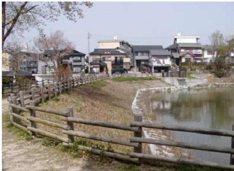
写真 2-6 雨水流出抑制施設としての整備例(丸藪池)
