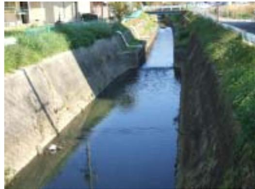
写真 2-7 コンクリート護岸 (逢妻男川)
