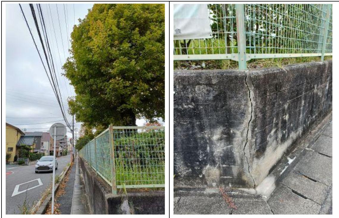
造成された公園等の擁壁、石垣等は、時の経過とともに、徐々に雨水や樹木の根による土圧により、ふくらみ、ひび割れが発生し、擁壁、石垣等の崩壊・倒壊による災害等の可能性もある。
