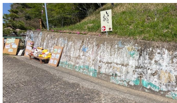
擁壁ペインティングを行います
