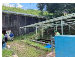
鉄骨を残し、木の支柱とネットを撤去
