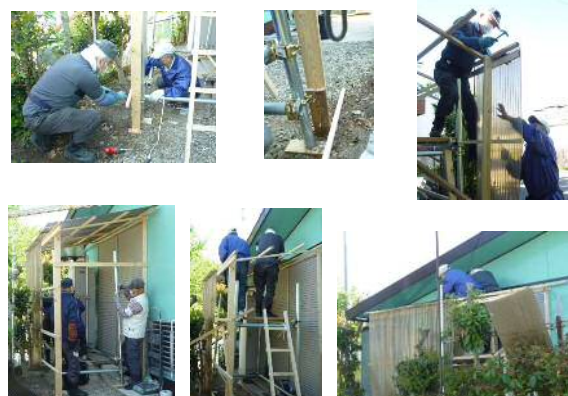
4月 27日 屋根の設置
