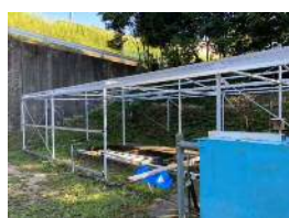
鉄骨の錆落とし再塗装
