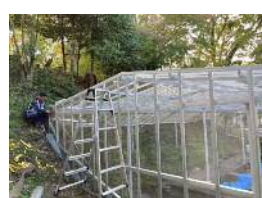
ネットを全面に貼付け固
