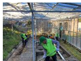
工事完了後、水路を掃除
