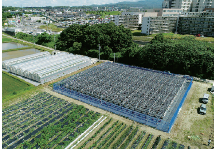
▲令和元年、浄水町に太啓建設が最初に手がけた営農型太陽光発電施設と温室。当初は発電施設下での水稲栽培をしていました。令和4年度には、ブルーベリー栽培に切り替わりました。
