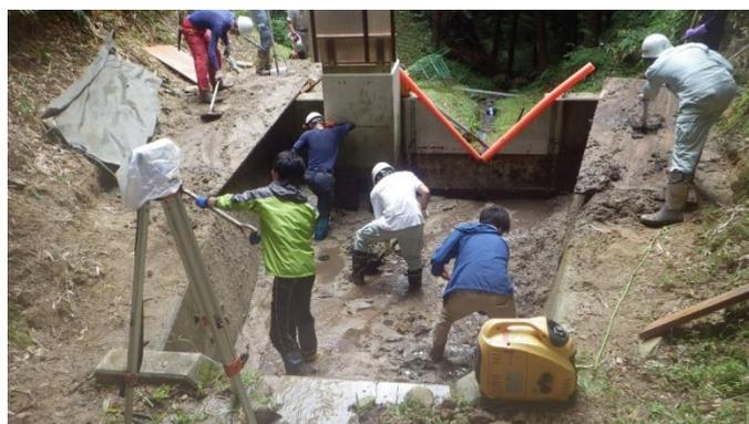
〈量水堰内の砂出し作業の様子〉
