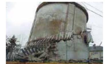
東日本大震災で崩壊した水道施設 (出典:「東日本大震災水道施設被害状況調査報告書 H24」厚生労働省)
