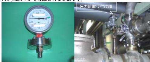
図3-1 脱落した圧力計
