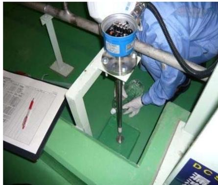
静電容量式漏洩検知器
